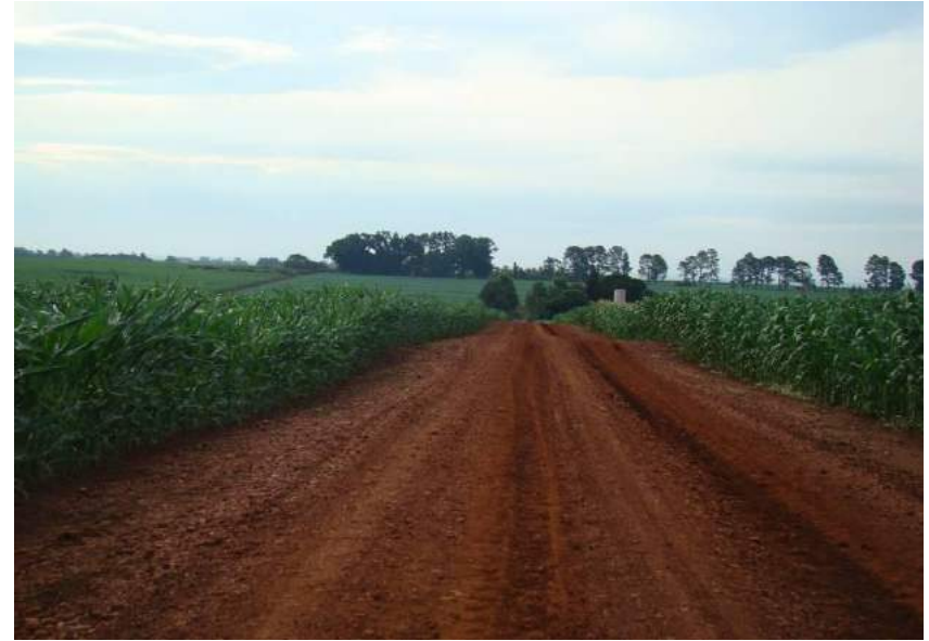
Figuras 263 e 264 – Plataforma não conformada e ausência de sistema de drenagem.
