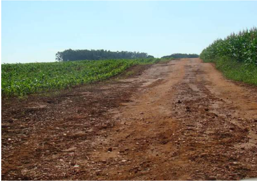
Figuras 52 e 53 – Plataforma não conformada e trecho sem revestimento.
