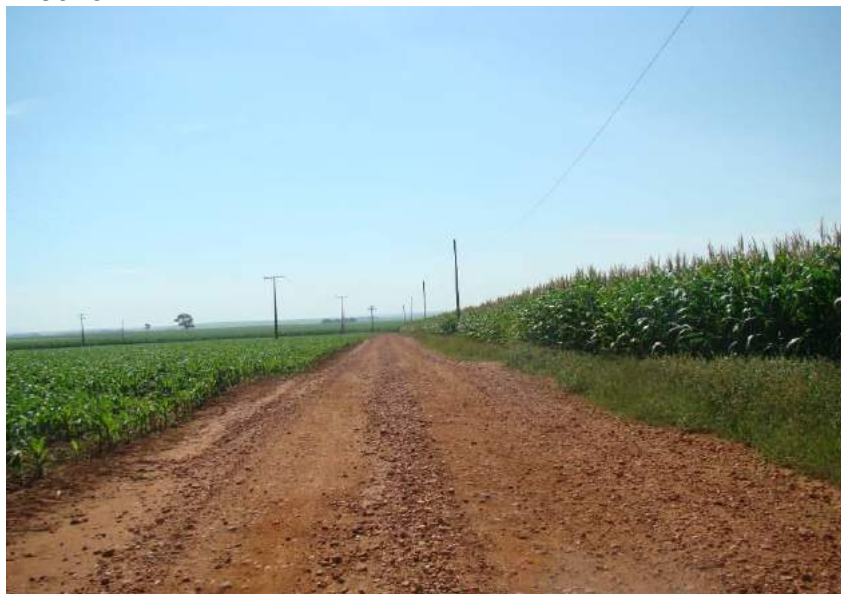
Figuras 44 e 45 – Costela de vaca e ausência de sistema de drenagem.
