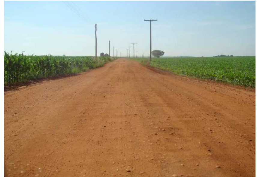
Figuras 18 e 19 – Ausência de sistema de drenagem e costela de vaca.
