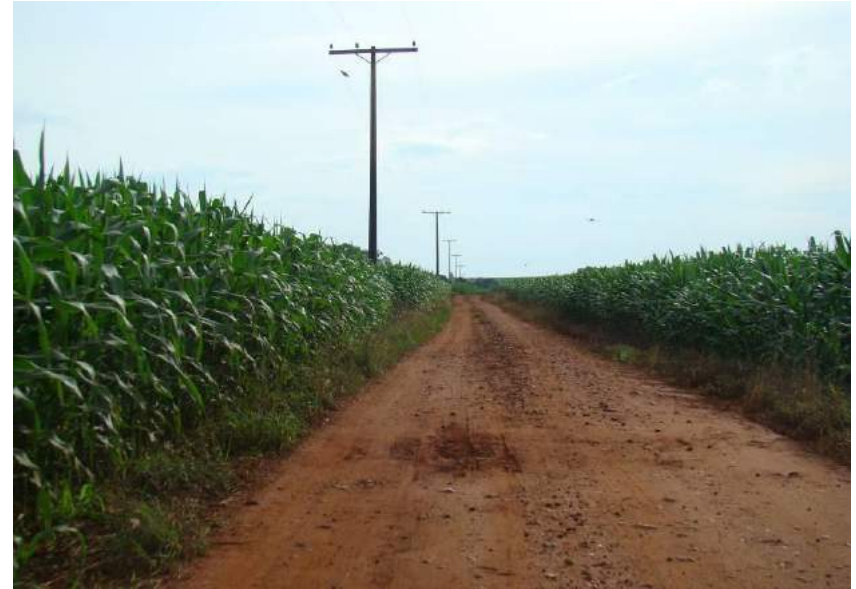
Figuras 205 e 206 – Trecho inicial da estrada e ausência de sistema de drenagem.
