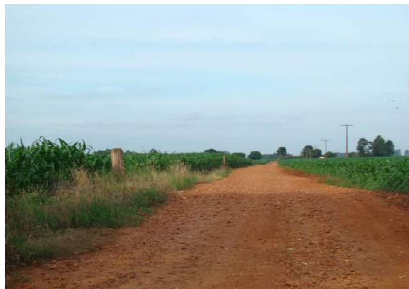
Figuras 223 e 224 – Sistema de drenagem não funcional e revestimento com pedregulho.
