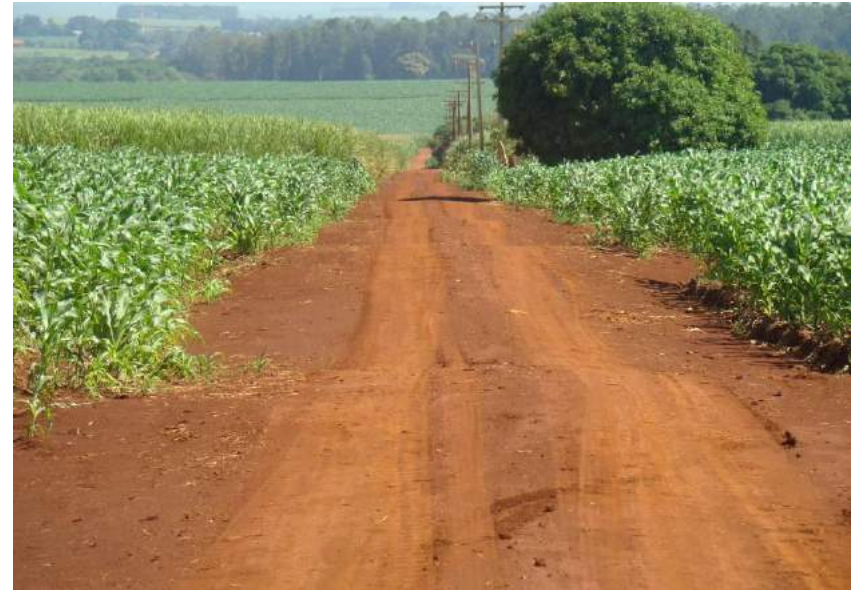
Figuras 126 e 127 – Plataforma não conformada e sistema de drenagem não funcional.
