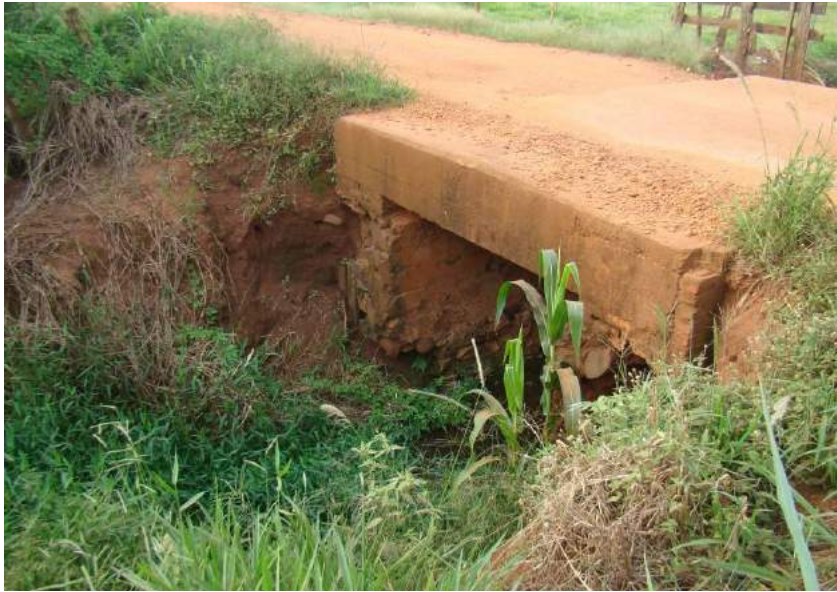
Figuras 229 e 230 – Ponte de pranchão de concreto e base em alvenaria.
