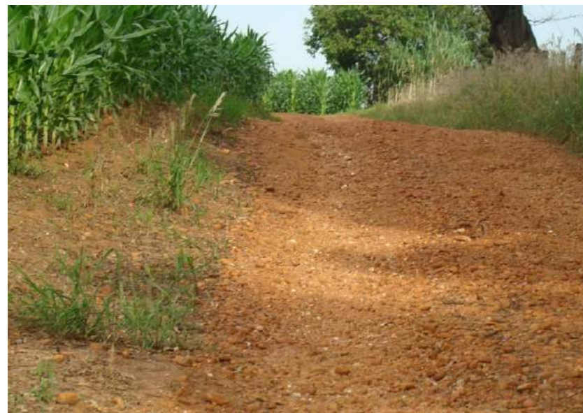
Figuras 211 e 212 – Indícios de enxurrada e revestimento com pedregulho.
