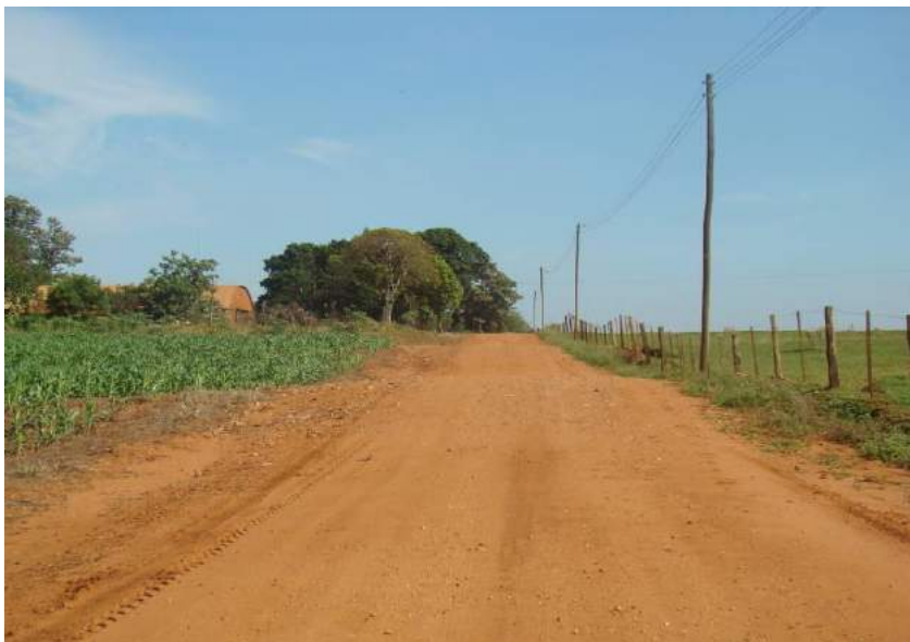
Figuras 20 e 21 – Camalhões e trecho sem revestimento.
