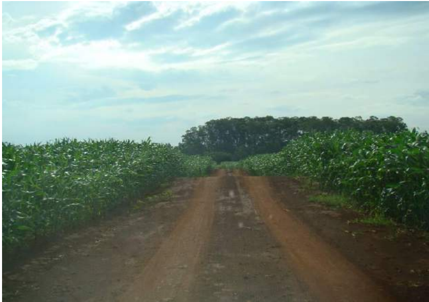
Figuras 196 e 197 – Formação de trilho de roda e ausência de sistema de drenagem.
