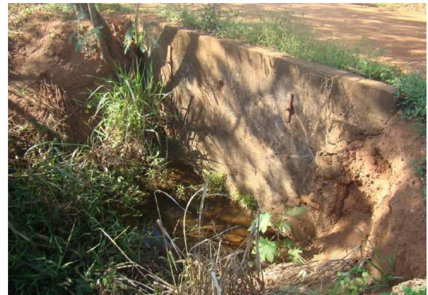
Figuras 32 e 33 – Árvores isoladas na jusante e tubulação parcialmente assoreada.
