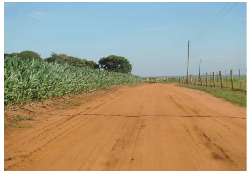
Figuras 20 e 21 – Camalhões e trecho sem revestimento.
