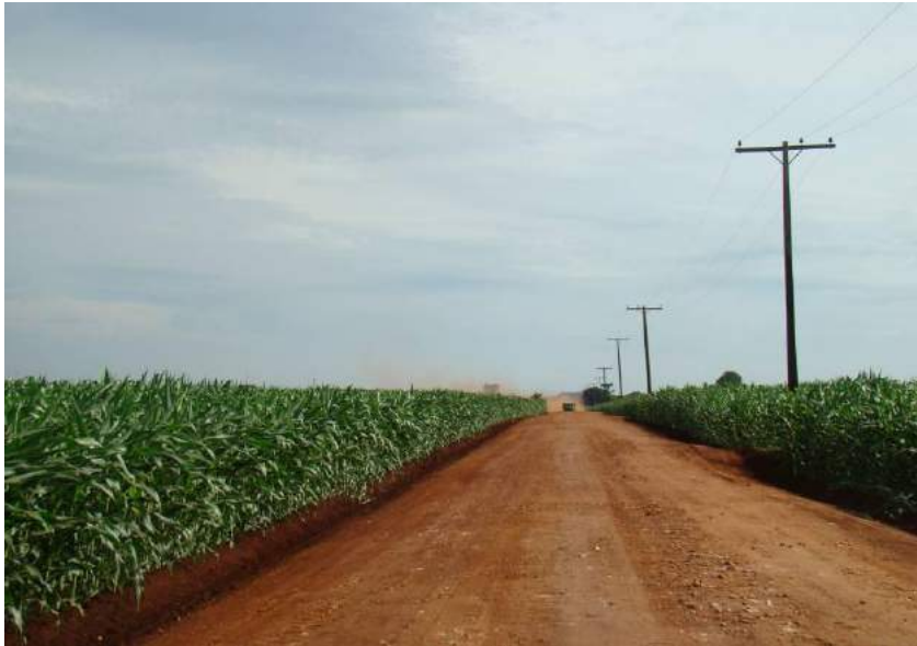
Figuras 157 e 158 – Ausência de sistema de drenagem e costela de vaca.
