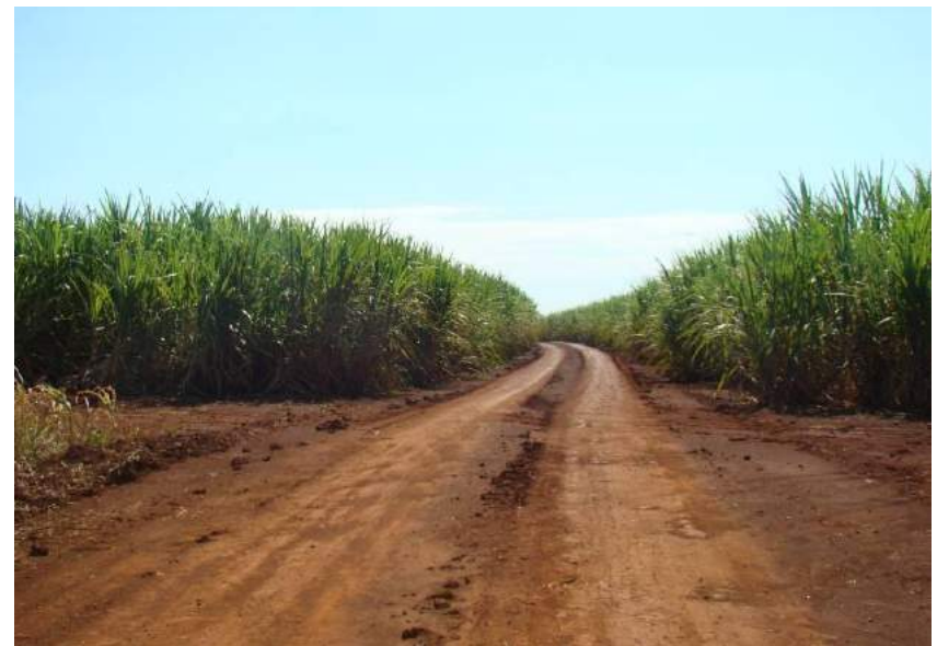
Figuras 91 e 92 – Traçado em meia encosta e trecho sem revestimento.
