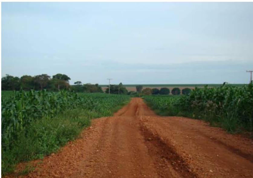
Figuras 239 e 240 – Plataforma não conformada e costela de vaca.
