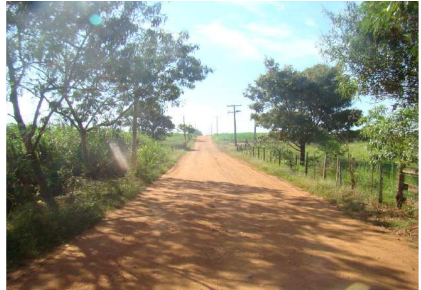
Figuras 26 e 27 – Ausência de sistema de drenagem.
