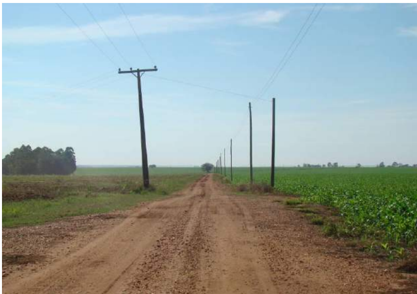
Figuras 24 e 25 – Trecho com revestimento de pedregulho e formação de trilho de roda.
