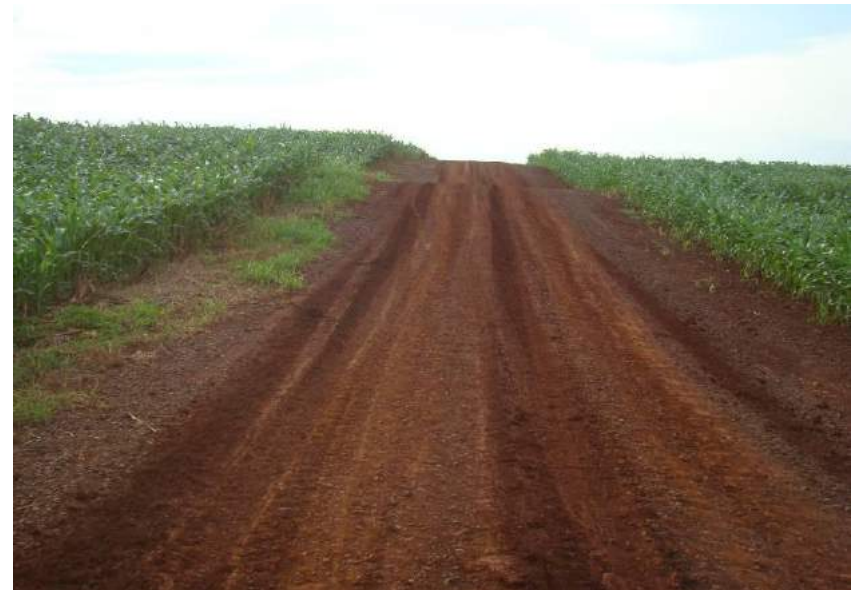
Figuras 261 e 262 – Pista escorregadia e trilho de roda.
