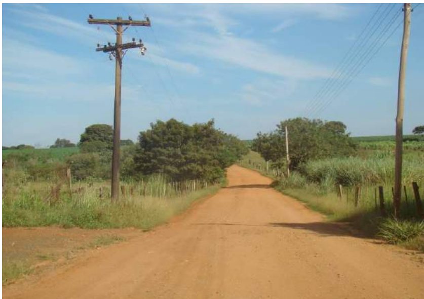
Figuras 16 e 17 – Plataforma não conformada e curva perigosa.
