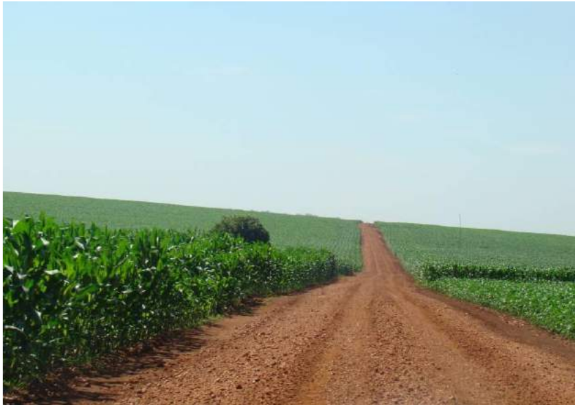
Figuras 85 e 86 – Ausência de sistema de drenagem e lombadas não funcionais.
