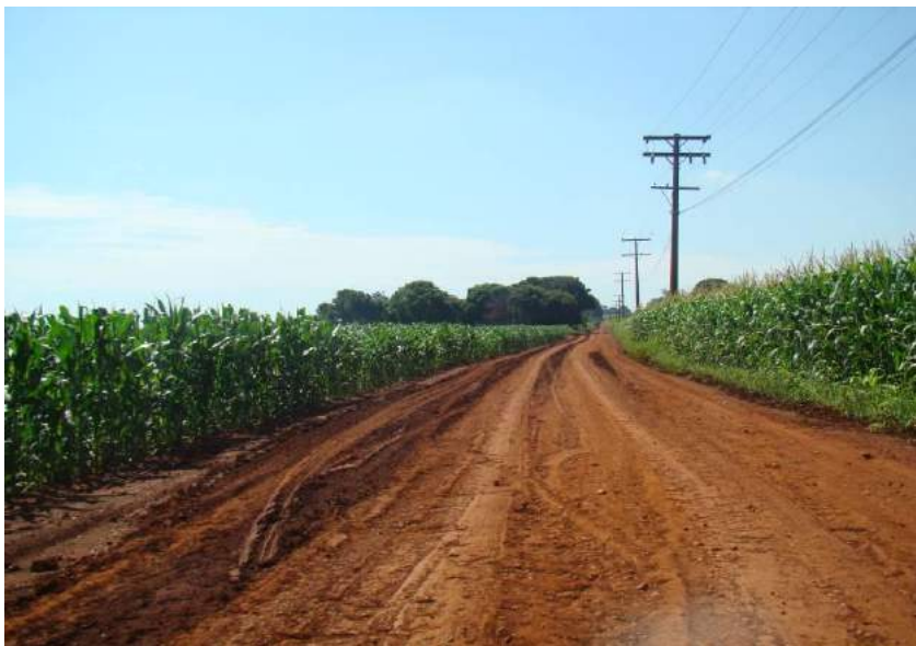
Figuras 111 e 112 – Pista escorregadia e trilho de roda.
