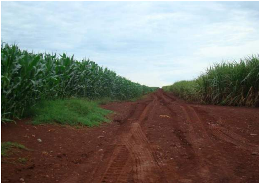
Figuras 277 e 278 – Trecho sem revestimento e indícios de encurrada.
