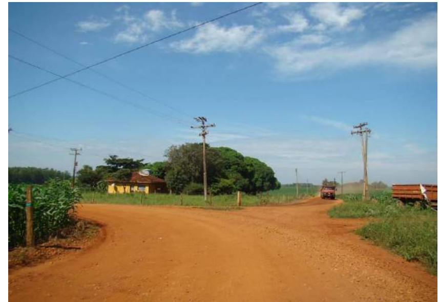
Figuras 67 e 68 – Ausência de sistema de drenagem e cruzamento com a estrada PPT - 060.
