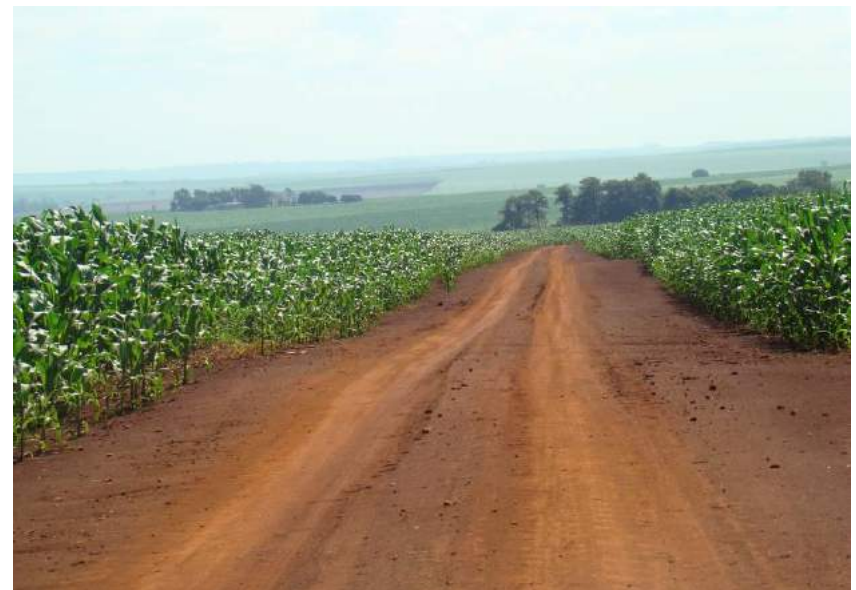
Figuras 115 e 116 – Trecho sem revestimento e ausência de sistema de drenagem.
