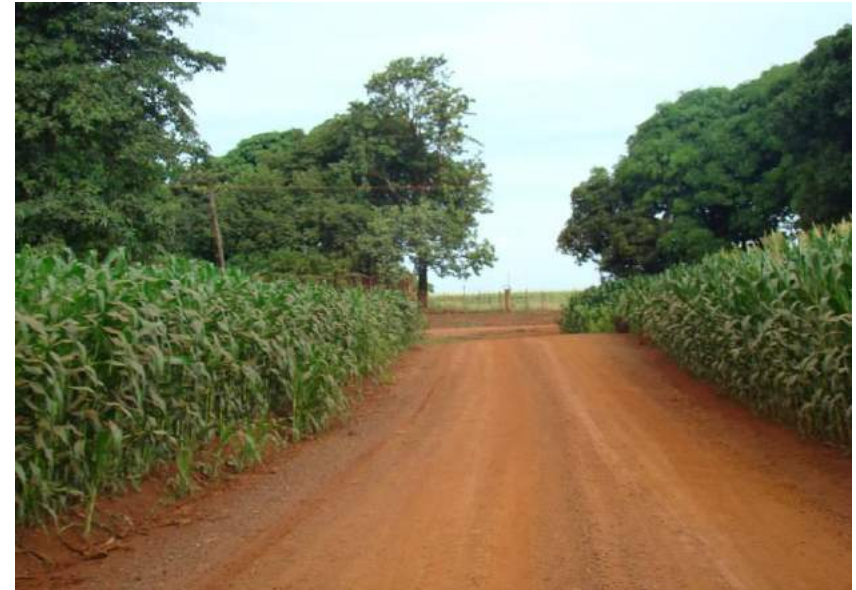
Figuras 192 e 193 – Costela de vaca e plataforma não conformada.
