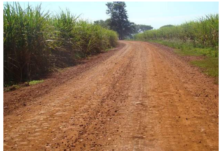
Figuras 87 e 88 – Plataforma não conformada e costela de vaca.
