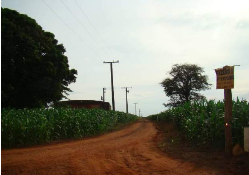
Figuras 205 e 206 – Trecho inicial da estrada e ausência de sistema de drenagem.
