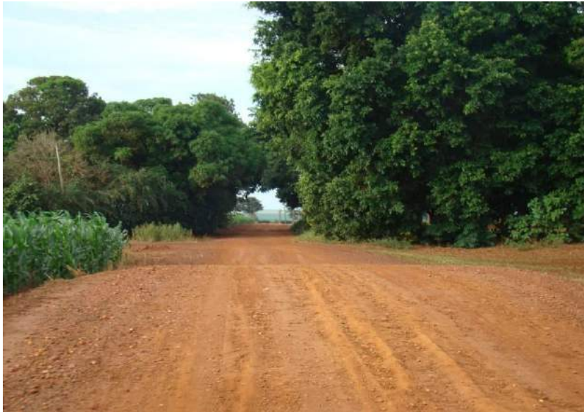
Figuras 245 e 246 – Plataforma não conformada e ausência de sistema de drenagem.
