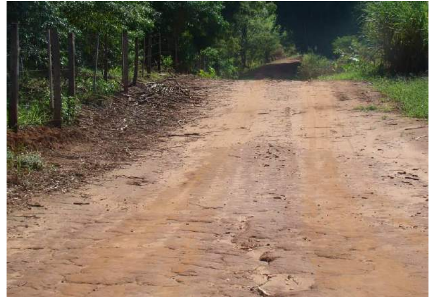
Figuras 48 e 49 – Plataforma não conformada e lombadas não funcionais.
