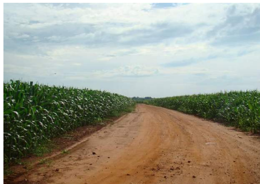
Figuras 165 e 166 – Ausência de sistema de drenagem e trecho sem revestimento.
