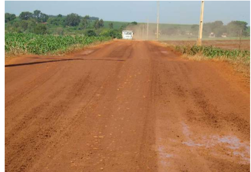
Figuras 69 e 70 – Plataforma não conformada e água jogada na estrada por caminhão pipa para diminuir poeiras.
