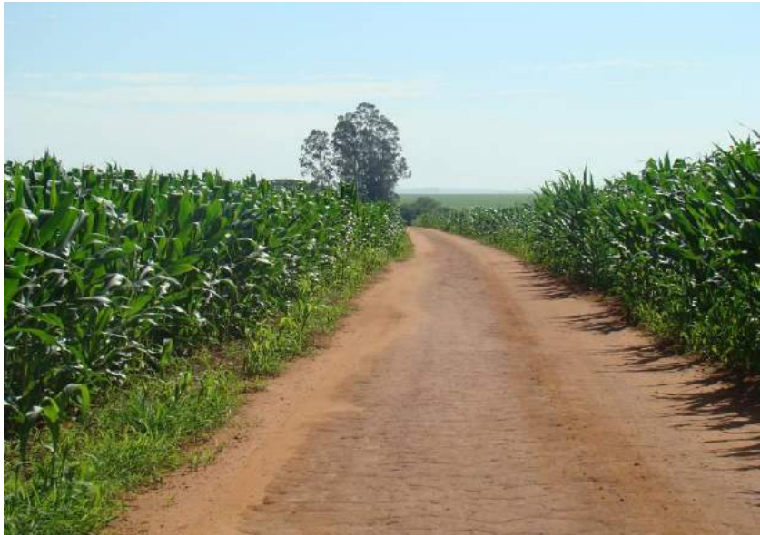
Figuras 48 e 49 – Plataforma não conformada e lombadas não funcionais.
