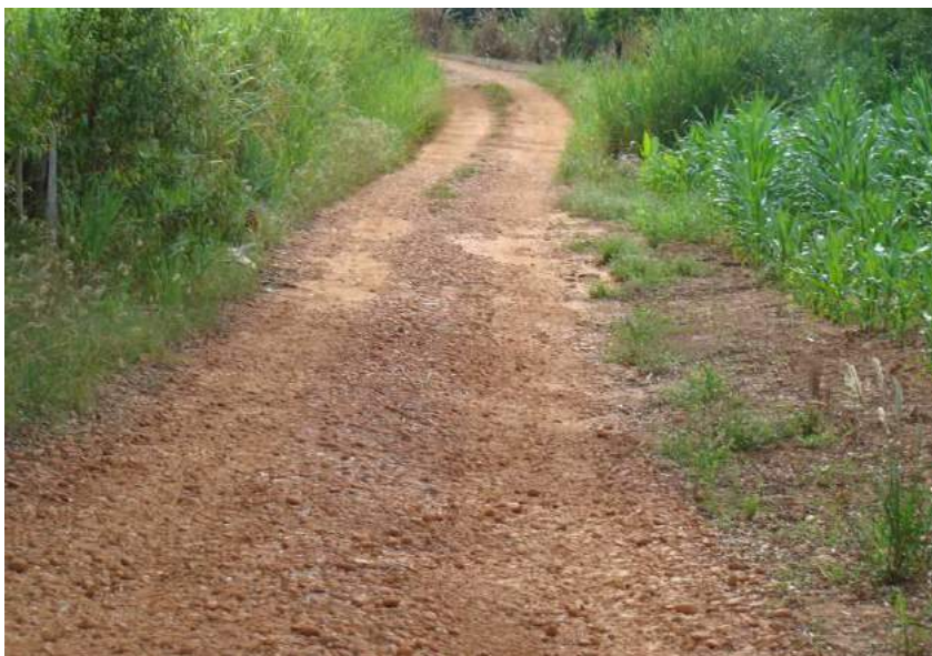
Figuras 211 e 212 – Indícios de enxurrada e revestimento com pedregulho.
