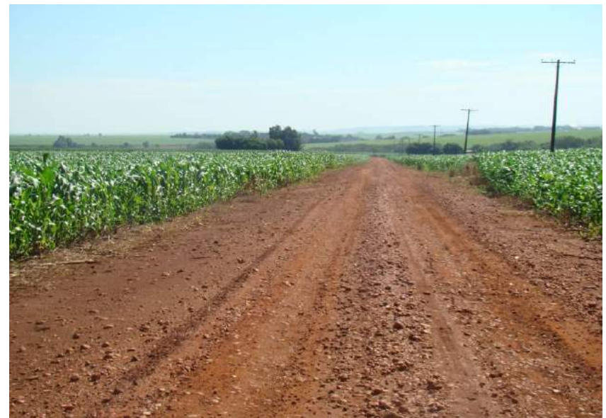
Figuras 63 e 64 – Trilho de roda e revestimento com pedregulho.
