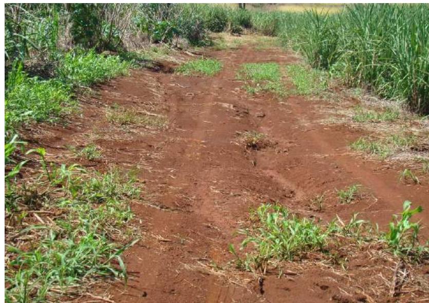
Figura 132 - Trecho final da estrada.
