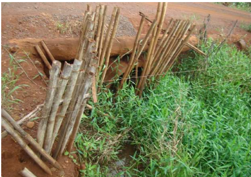
Figuras 186 e 187 – Tubulação sem ala de saia e processo erosivo no aterro.
