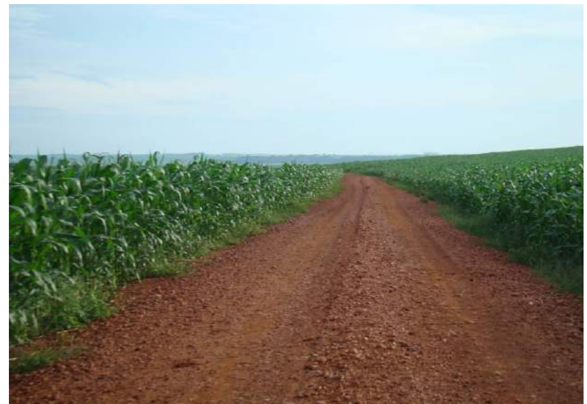
Figuras 239 e 240 – Plataforma não conformada e costela de vaca.
