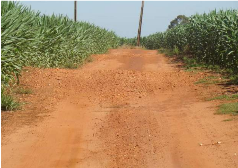
Figuras 65 e 66 – Lombadas não funcionais e pista escorregadia sobre pedras soltas.
