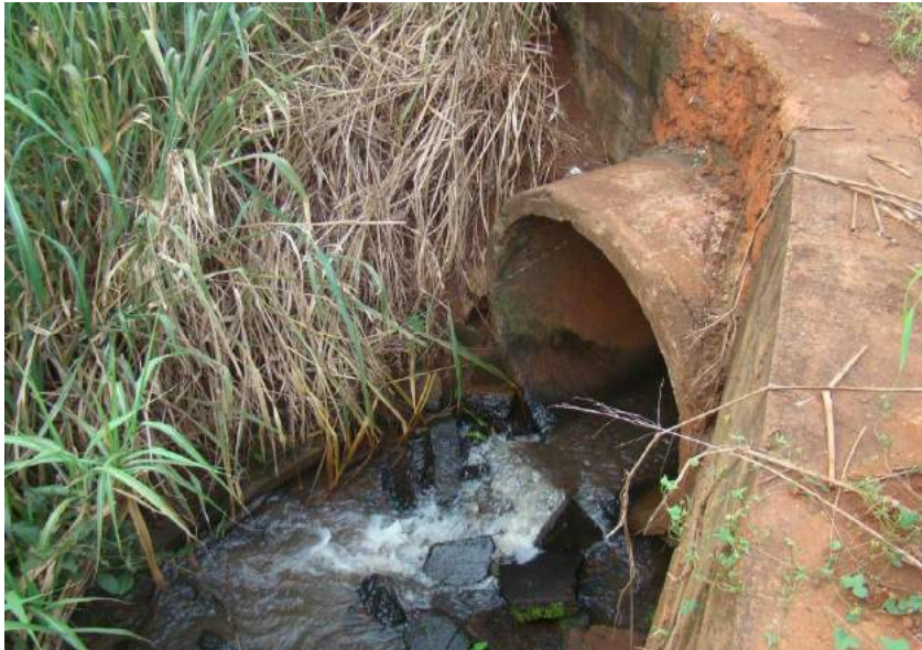
Figuras 273 e 274 – Tubulação em ala de saia de alvenaria e passagem sobre o Córrego do Pica Pau.
