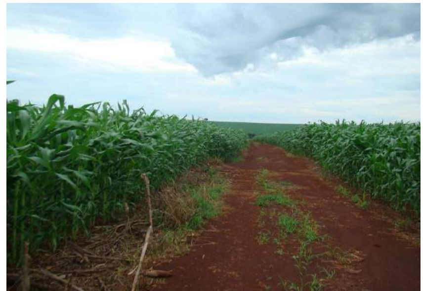
Figuras 304 e 305 – Ausência de sistema de drenagem e trilho de roda.
