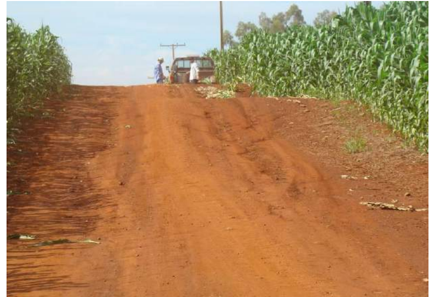
Figuras 161 e 162 – Sistema de drenagem não funcional e indícios de enxurrada.
