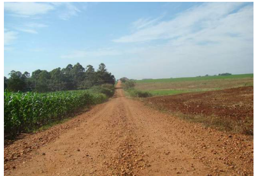
Figuras 36 e 37 – Trilho de roda e revestimento com pedregulho.
