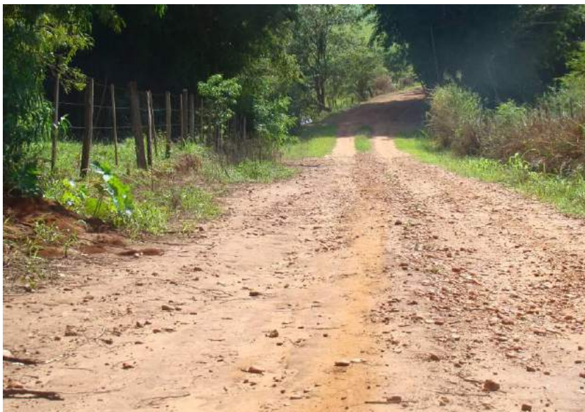
Figuras 50 e 51 – Trilho de roda e pista escorregadia.
