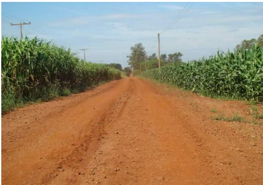
Figuras 63 e 64 – Trilho de roda e revestimento com pedregulho.
