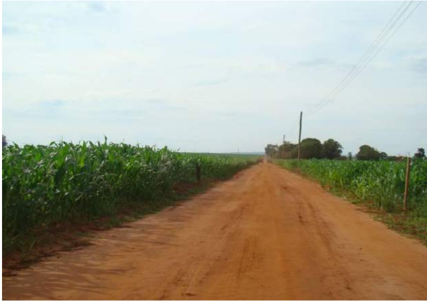
Figuras 200 e 201 – Plataforma não conformada e ausência de sistema de drenagem.
