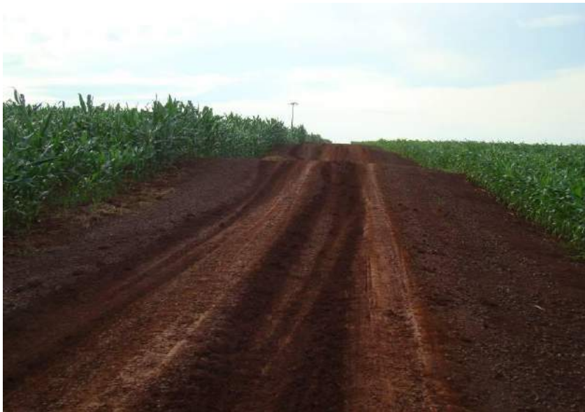
Figuras 261 e 262 – Pista escorregadia e trilho de roda.
