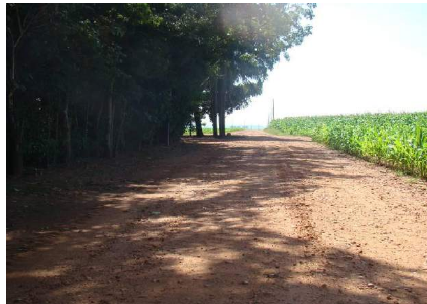
Figuras 44 e 45 – Costela de vaca e ausência de sistema de drenagem.
