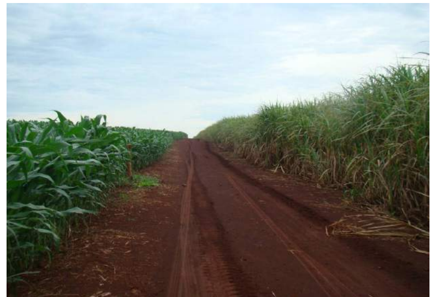
Figuras 279 e 280 – Pista escorregadia e ausência de sistema de drenagem.
