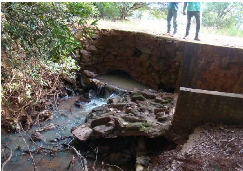
Figuras 248 e 249 – Tubulação com ala de saída em gabião e vegetação de gramíneas em APP.
