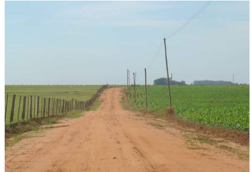
Figuras 22 e 23 – Formação de areião e trecho sem saída de água.
