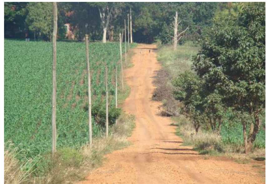
Figuras 28 e 29 – Pouco revestimento e trecho de aclave e declive.
