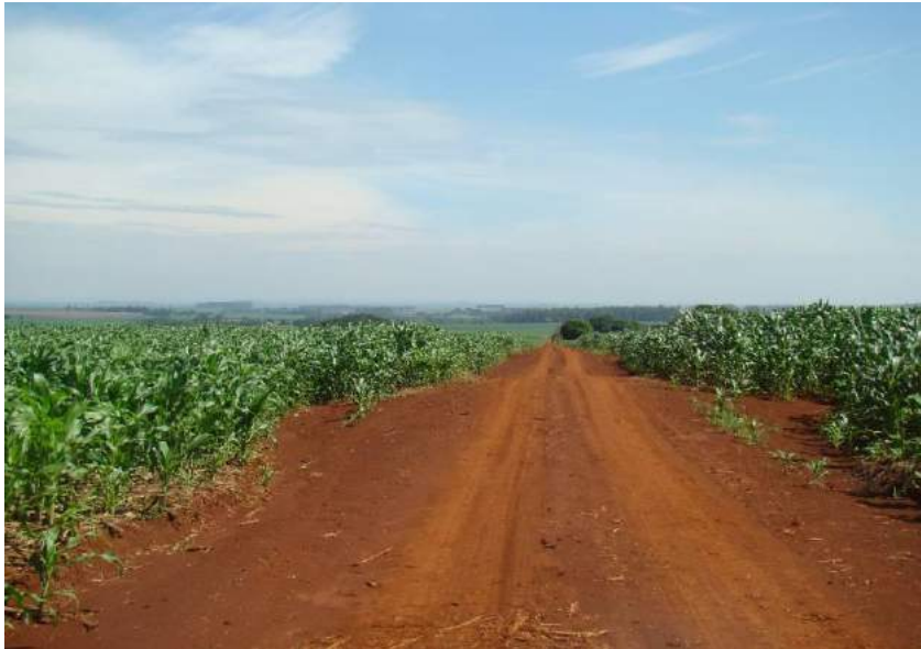
Figuras 126 e 127 – Plataforma não conformada e sistema de drenagem não funcional.
