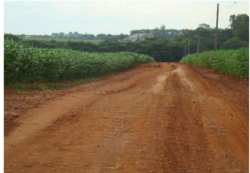
Figuras 245 e 246 – Plataforma não conformada e ausência de sistema de drenagem.
