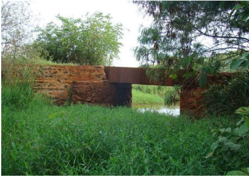
Figuras 171 e 172 – Ponte de prancha de concreto e ala de saia em gabião.
