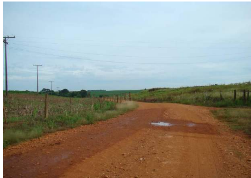
Figuras 225 e 226 – Ausência de sistema de drenagem e poça d'água.
