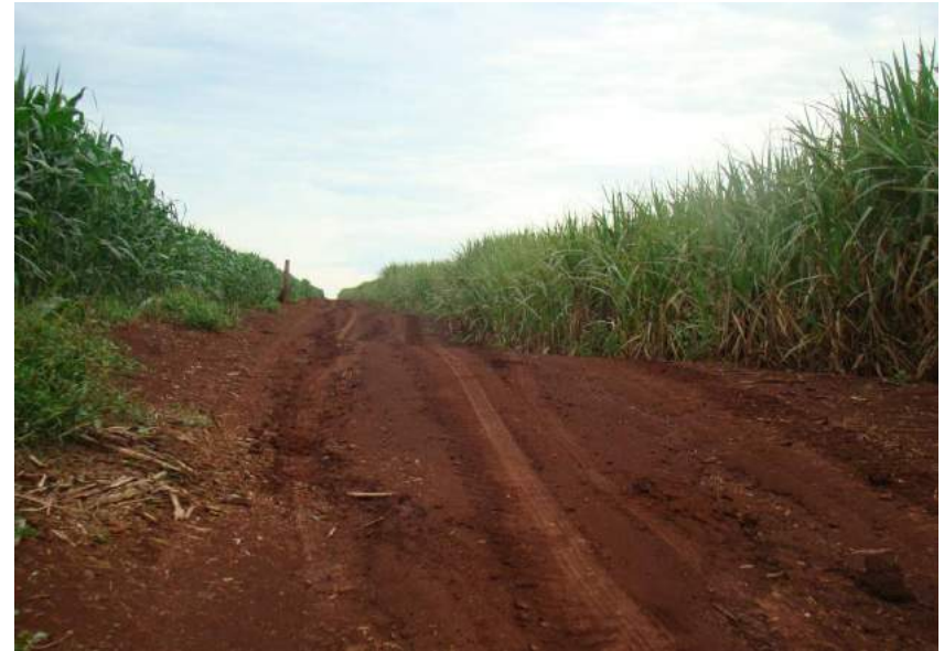
Figuras 277 e 278 – Trecho sem revestimento e indícios de encurrada.
