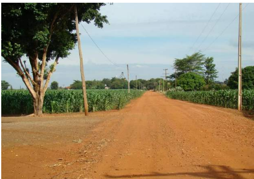
Figuras 165 e 166 – Ausência de sistema de drenagem e trecho sem revestimento.
