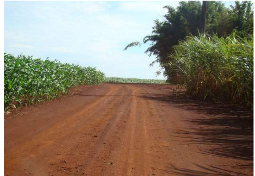
Figuras 137 e 138 – Costela de vaca e plataforma não conformada.
