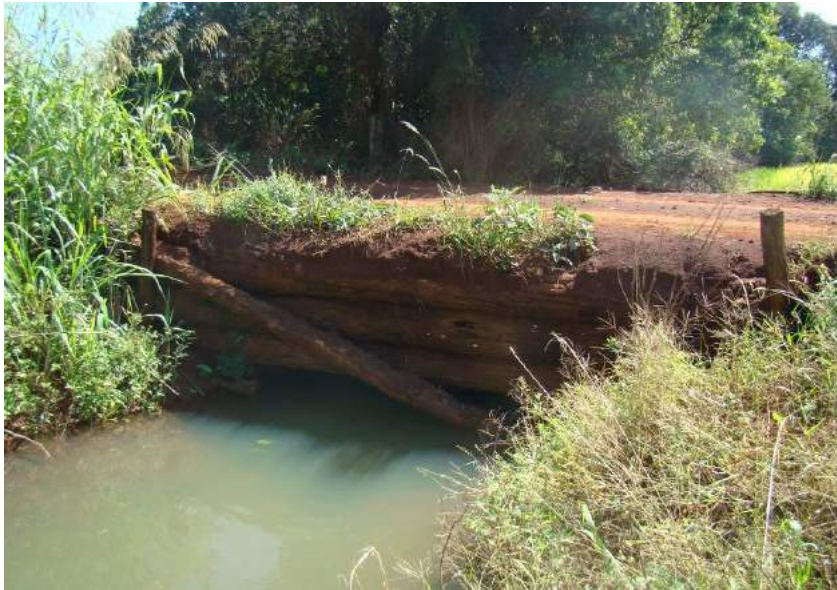
Figuras 97 e 98 – Ponte em longarinas de madeira e passagem sobre o Ribeirão do Bugio.
