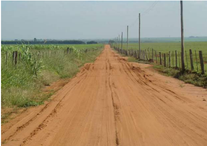
Figuras 22 e 23 – Formação de areião e trecho sem saída de água.
