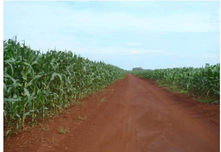
Figuras 147 e 148 – Plataforma não conformada e sem revestimento.
