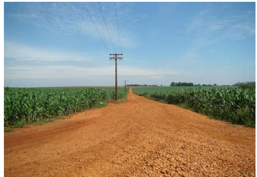
Figuras 103 e 104 – Ausência de sistema de drenagem e pedras soltas sobre a estrada.
