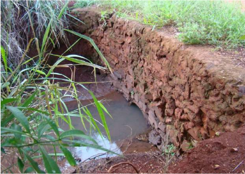
Figuras 255 e 256 – Tubulação com ala de saia em gabião e árvores isoladas na montante.
