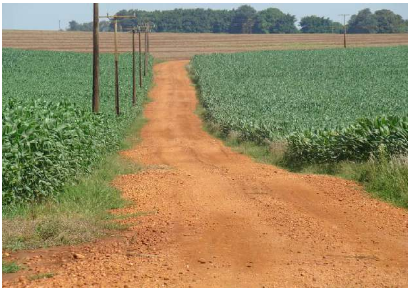
Figuras 105 e 106 – Plataforma não conformada e curva perigosa.
