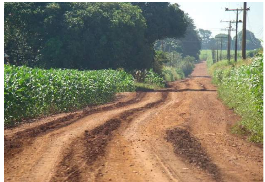
Figuras 111 e 112 – Pista escorregadia e trilho de roda.
