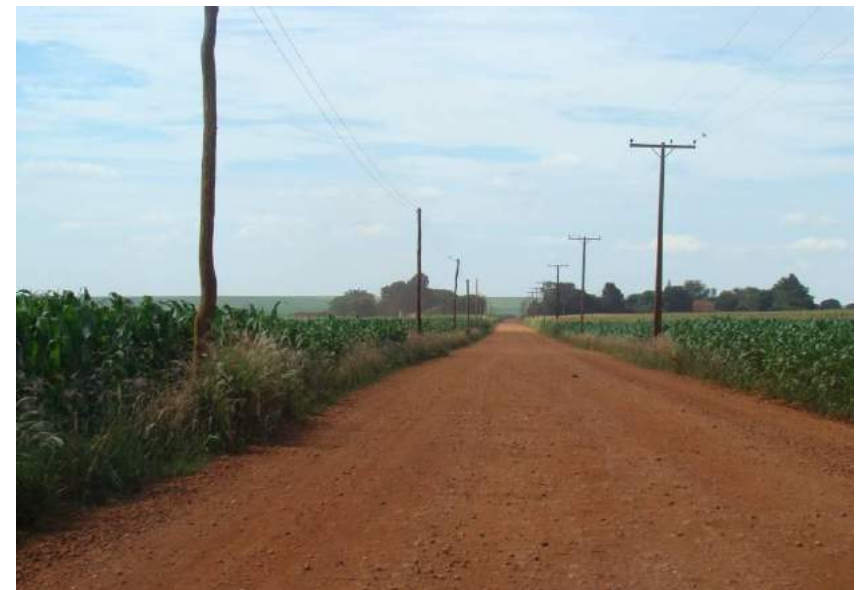
Figuras 135 e 136 – Revestimento com pedregulho e ausência de sistema de drenagem.
