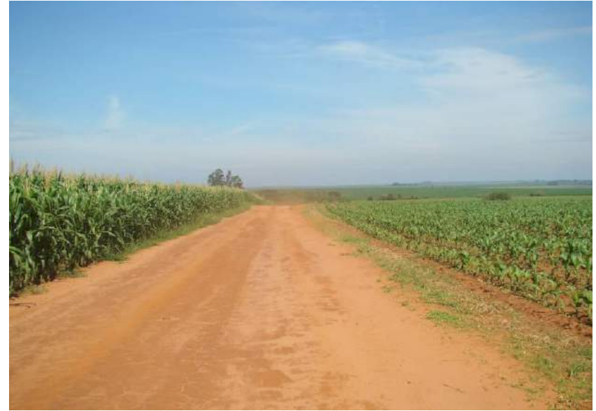
Figuras 52 e 53 – Plataforma não conformada e trecho sem revestimento.
