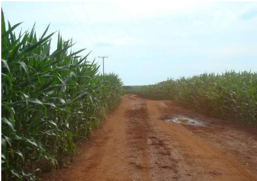
Figuras 207 e 208 – Poça d'água e plataforma não conformada.
