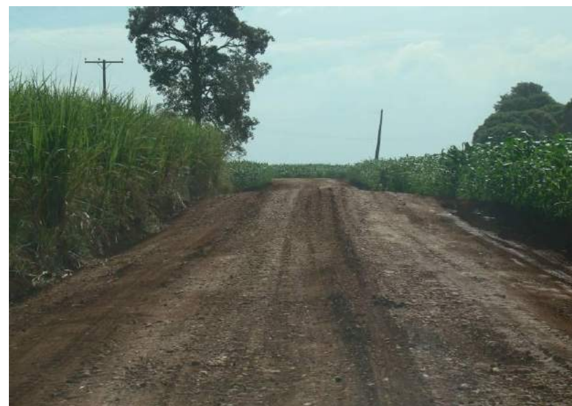
Figuras 155 e 156 – Formação de leiras na lateral da estrada e pista escorregadia.
