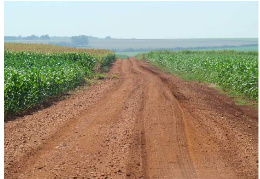
Figuras 85 e 86 – Ausência de sistema de drenagem e lombadas não funcionais.
