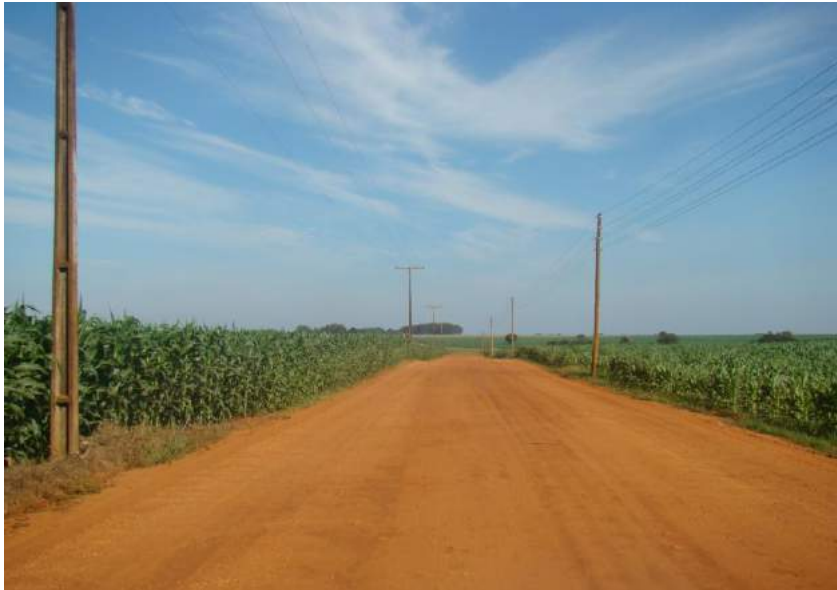
Figuras 26 e 27 – Ausência de sistema de drenagem.
