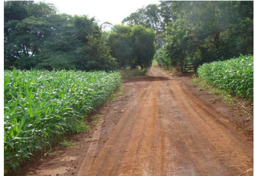
Figuras 196 e 197 – Formação de trilho de roda e ausência de sistema de drenagem.
