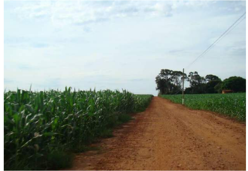
Figuras 200 e 201 – Plataforma não conformada e ausência de sistema de drenagem.
