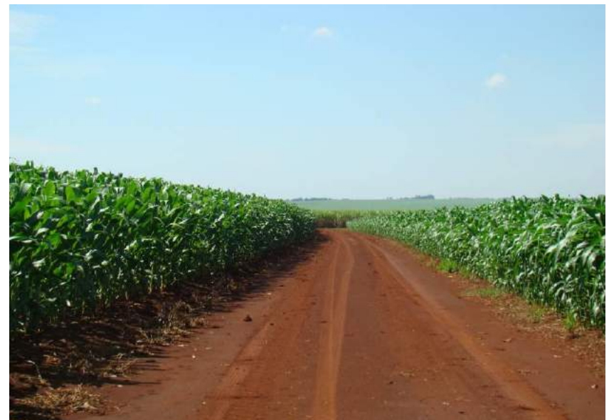
Figuras 120 e 121 – Formação de trilho de roda e trecho sem revestimento.
