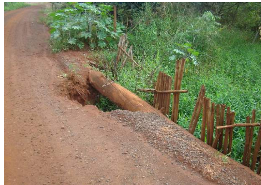
Figuras 186 e 187 – Tubulação sem ala de saia e processo erosivo no aterro.
