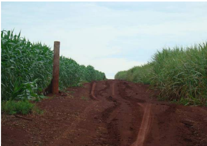
Figuras 279 e 280 – Pista escorregadia e ausência de sistema de drenagem.
