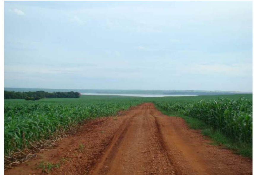
Figuras 237 e 238 – Trilho de roda e sistema de drenagem não funcional.
