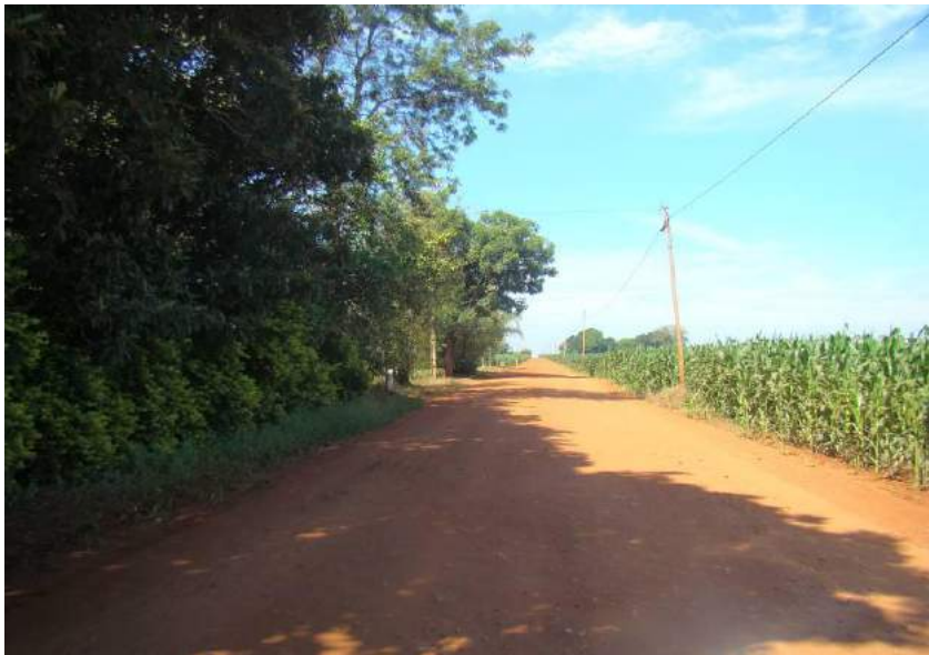
Figuras 67 e 68 – Ausência de sistema de drenagem e cruzamento com a estrada PPT - 060.
