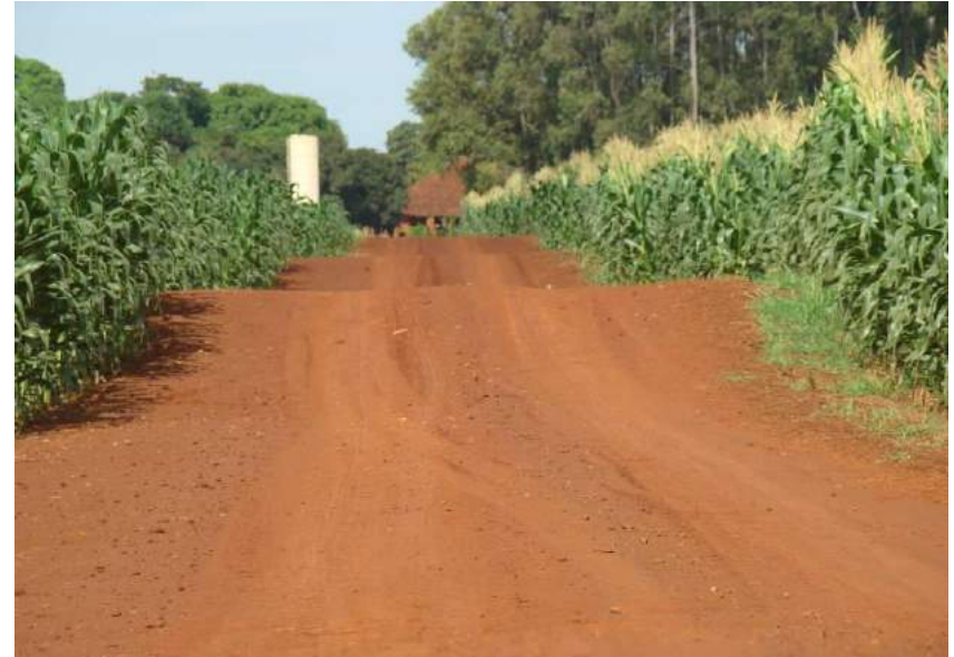
Figuras 151 e 152 – Formação de trilho de roda e lombadas.
