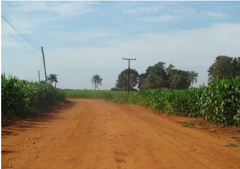
Figuras 18 e 19 – Ausência de sistema de drenagem e costela de vaca.
