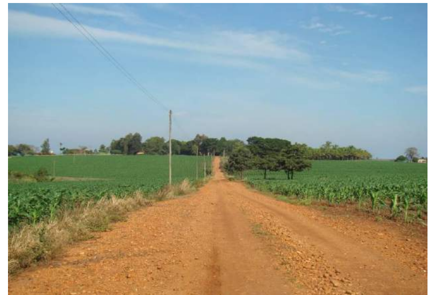
Figuras 24 e 25 – Trecho com revestimento de pedregulho e formação de trilho de roda.
