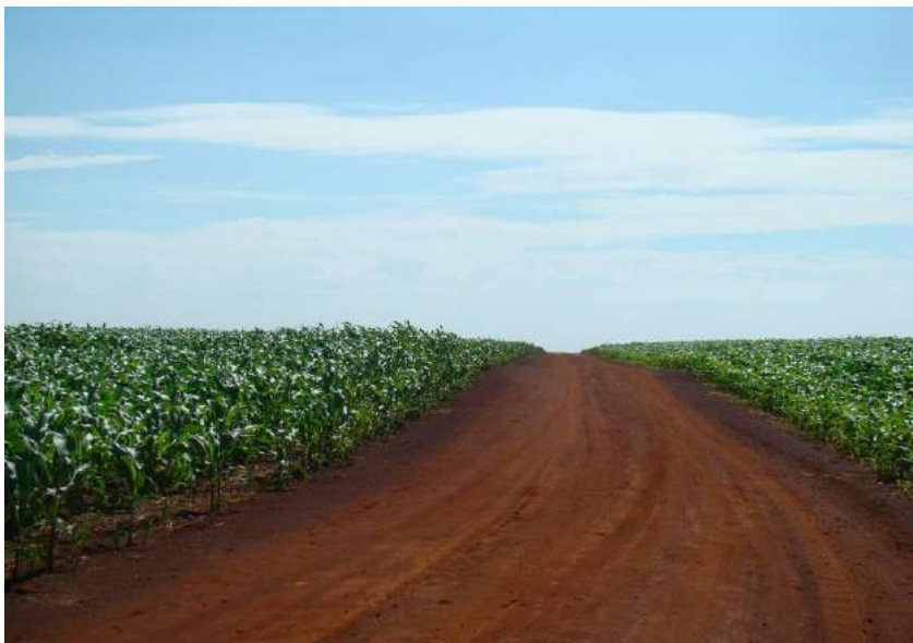
Figuras 115 e 116 – Trecho sem revestimento e ausência de sistema de drenagem.
