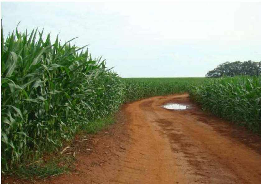
Figuras 209 e 210 – Poça d'água em curva e sistema de drenagem não funcional.
