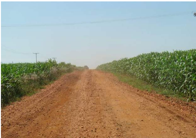
Figuras 103 e 104 – Ausência de sistema de drenagem e pedras soltas sobre a estrada.
