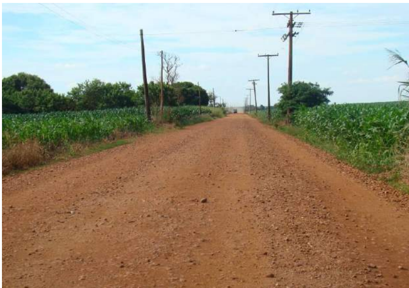
Figuras 135 e 136 – Revestimento com pedregulho e ausência de sistema de drenagem.
