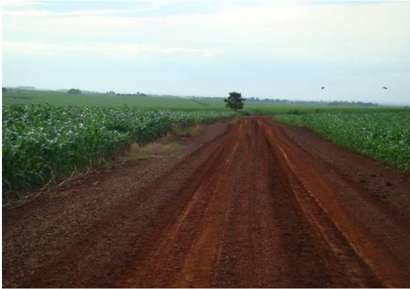
Figuras 263 e 264 – Plataforma não conformada e ausência de sistema de drenagem.
