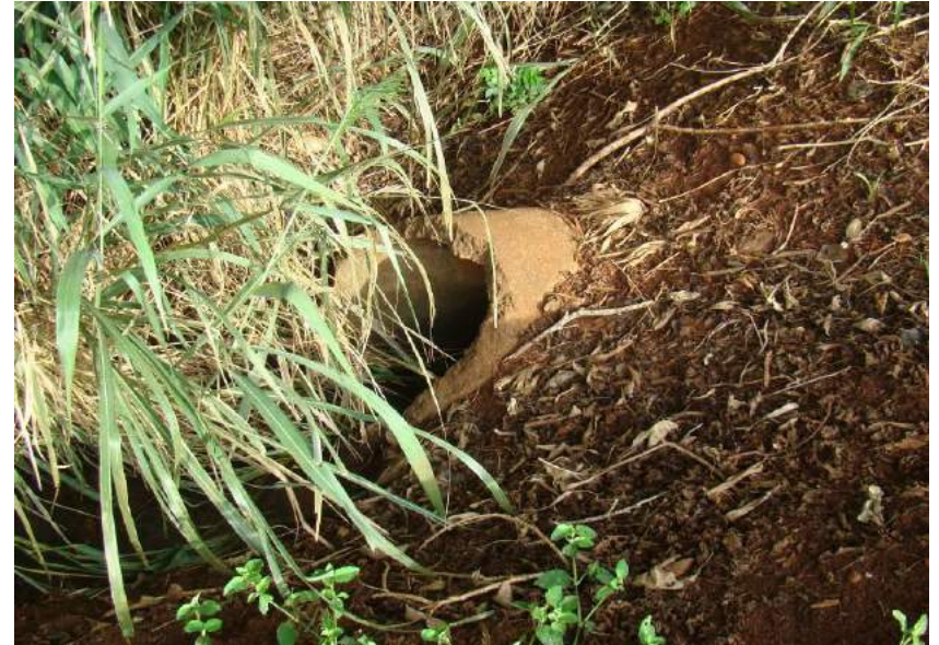
Figuras 253 e 254 – Árvores isoladas e tubulação sem ala de saia.
