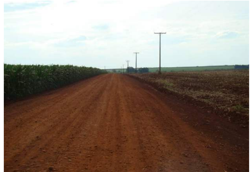
Figuras 157 e 158 – Ausência de sistema de drenagem e costela de vaca.
