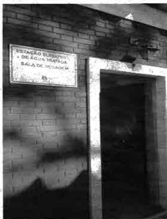
Foto 3.2 – Sala de Dosagem e EEAT
